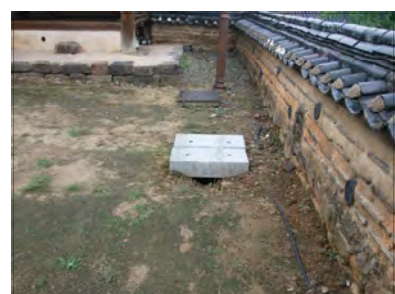
중정의 토사유실 및 침하로 인한 물고임 - 맨홀로 물이 유도되지 않음
