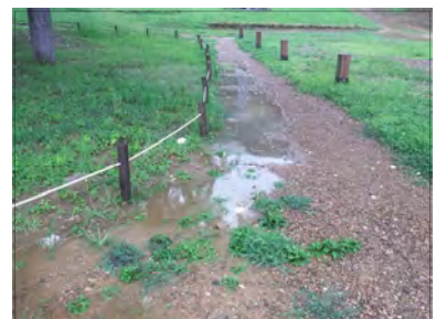
빗물을 맨홀로 유도하는 배수로 불량으로 인한 물고임
