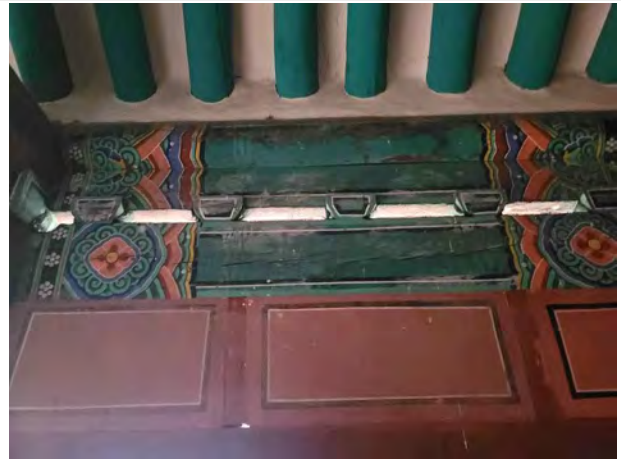
그림 50 태산사 내부 단청 박락 및 곰팡이 현황 2
