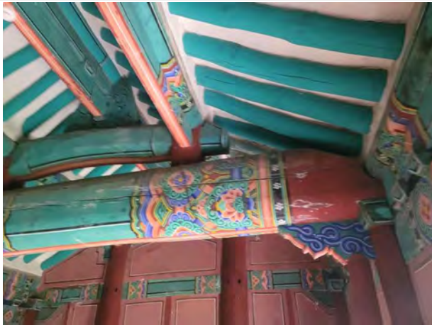
그림 49 태산사 내부 단청 박락 및 곰팡이 현황 1
