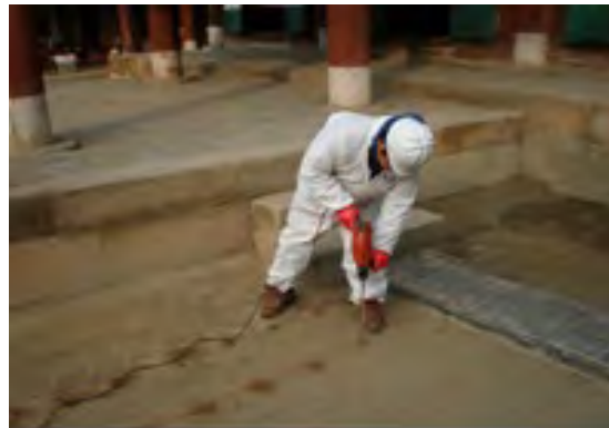
▲ 현재 사용중인 흰개미 방제방법 (좌: 훈증, 중: 토양처리, 우: 방충방부제 도포)
